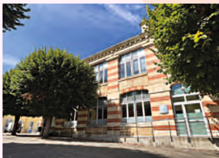
▲ L'école Louis-Pasteur a été entièrement rénovée et réaménagée. ©Ville de Gannat
